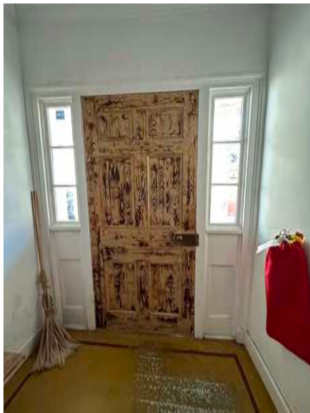
D: Door D1 looking W
