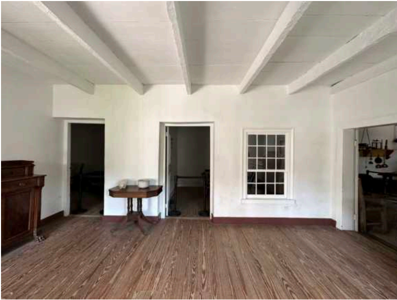
A: Room 107, looking NE
