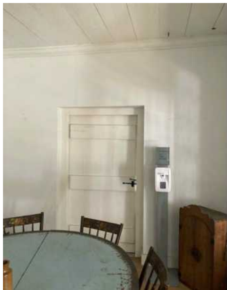
G: Door D10 looking E
