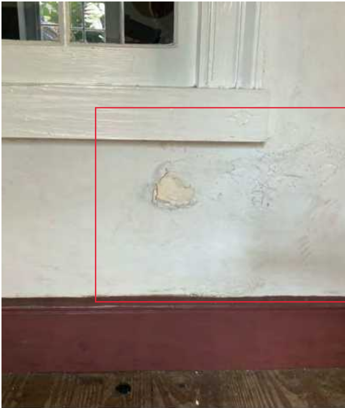
A: Room 107, looking N
