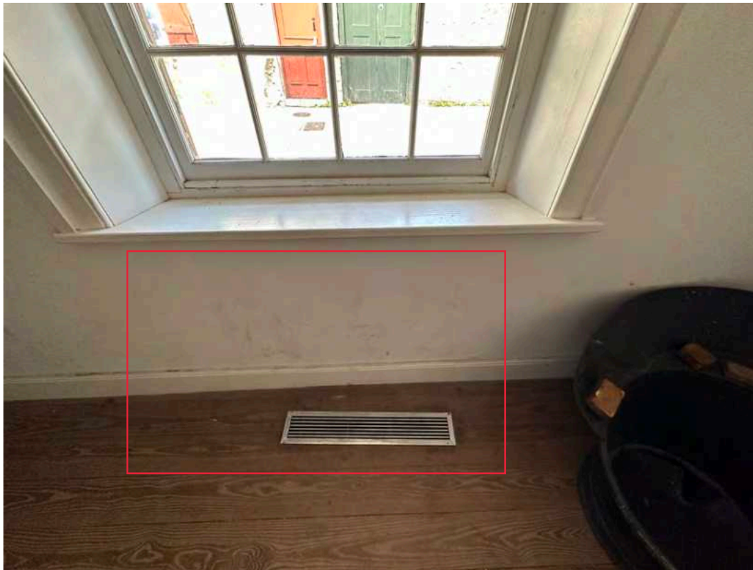
A: Room 103, looking W
