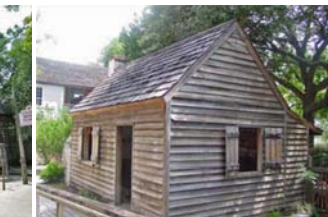
3913 Peso De Burgo N Outbuilding
